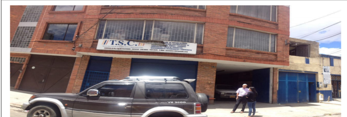
Fotografía No. 1: Panorámica del Aviso del establecimiento TSC TRATAMIENTOS DE SUPERFICIES S.A.S. ubicado en la Carrera 56 B No. 71-34
